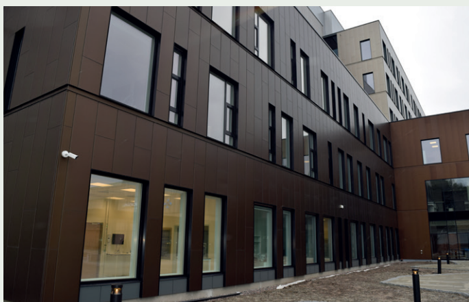
Fasade mot vest på somatikkbygget.
